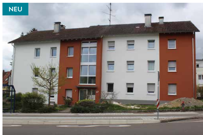
Anton-Bruckner-Str. 47 – Vor und nach der Sanierung
